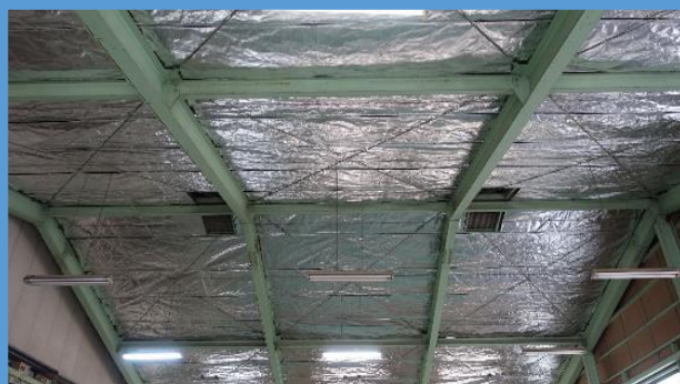
キープサーモウォール施工倉庫
