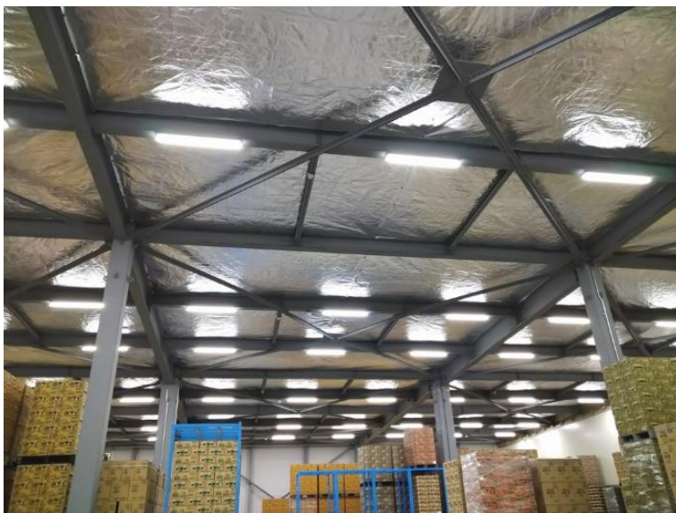
大阪府 飲料メーカー 物流倉庫 8,242㎡
