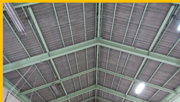
施工無し倉庫
