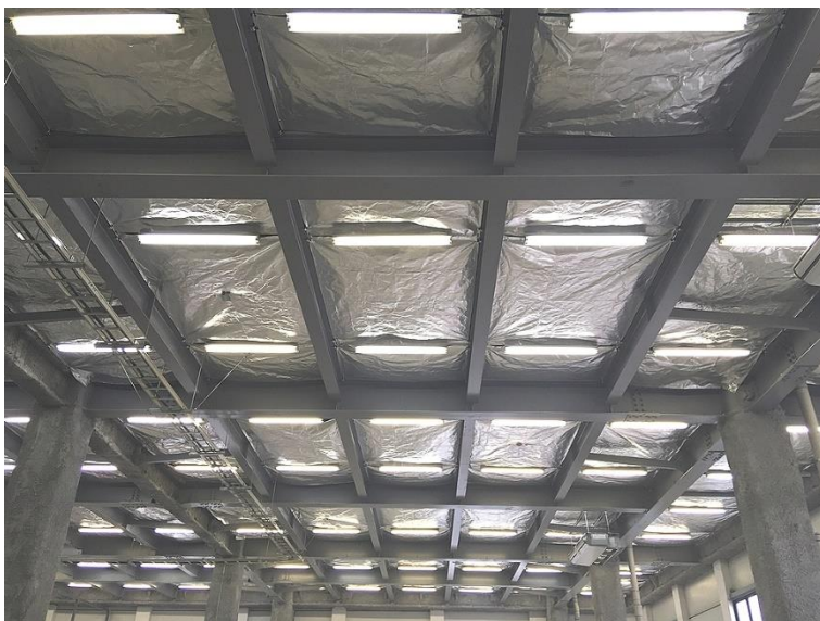
東京都 物流倉庫 1,034㎡
