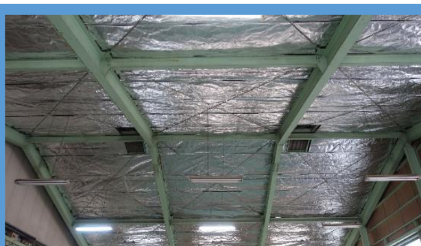
キープサーモウォール施工倉庫
